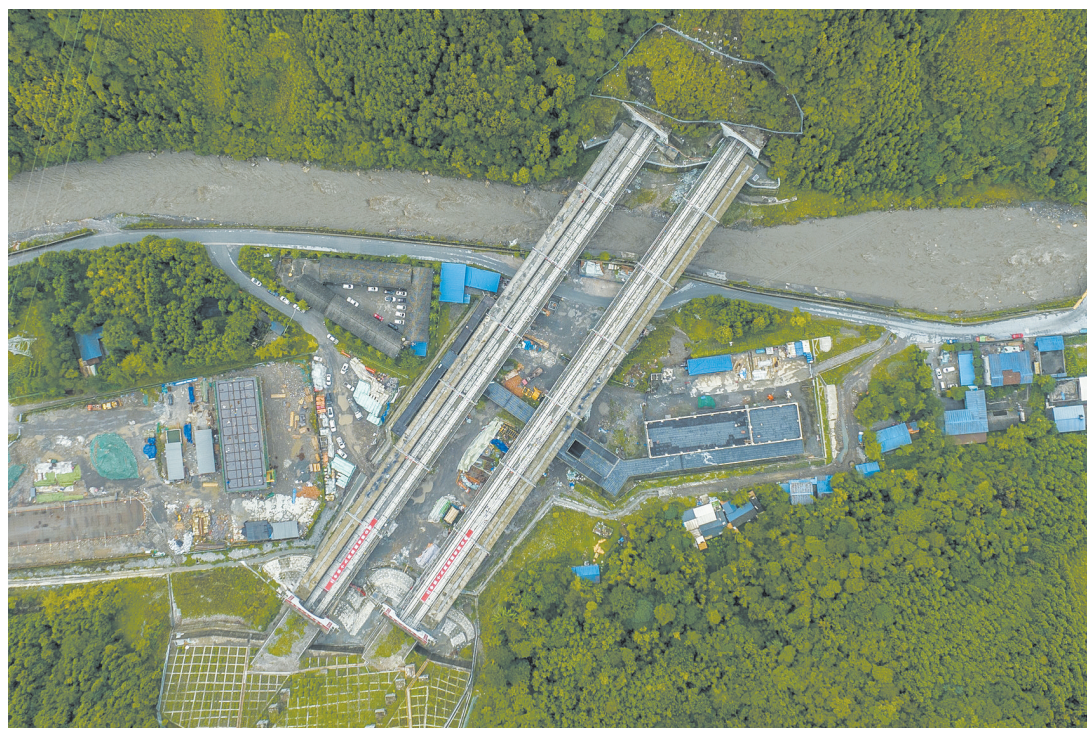
铁路铺过成兰铁路高川站,该车站位于柿子园隧道和跃龙门隧道间。 成兰铁路公司供图
