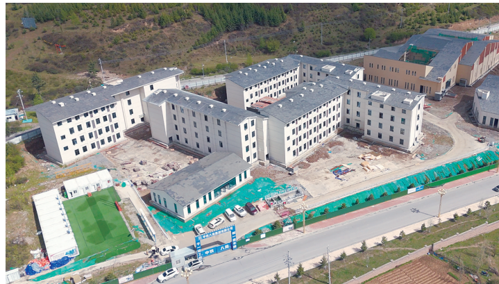
松潘校区项目建设现场
