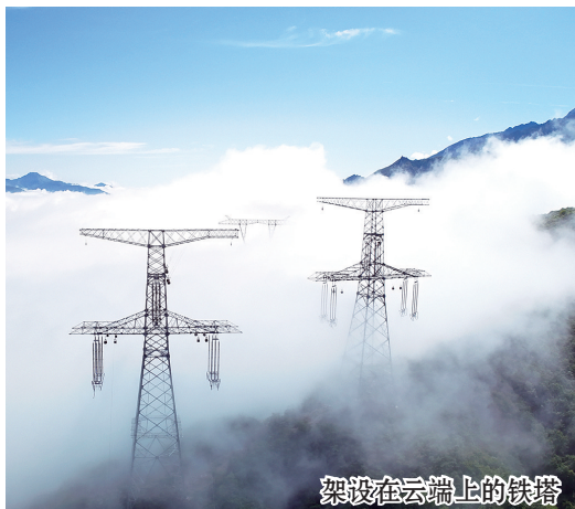
架设在云端上的铁塔
