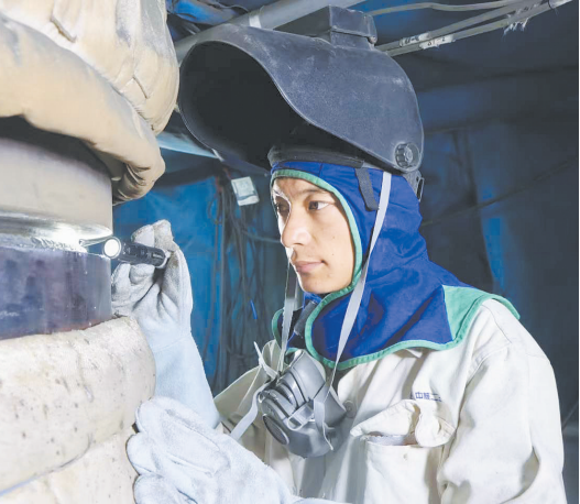
2025年5月,尔基在田湾核电八号机组进行主管道焊接作业 图片由本人提供
