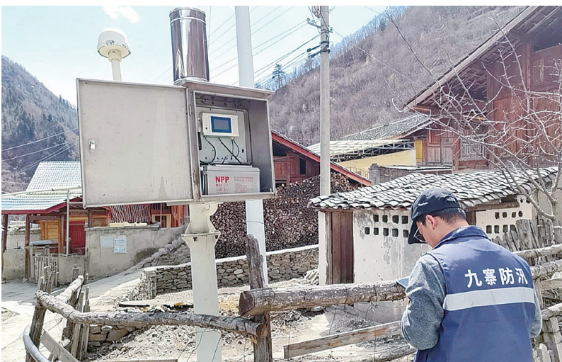
工作人员例行检查测雨雷达及预警终端运行状态
