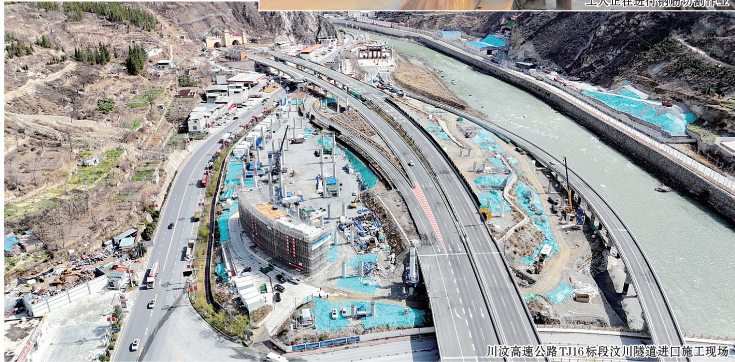
川汶高速公路TJ16标段汶川隧道进口施工现场
