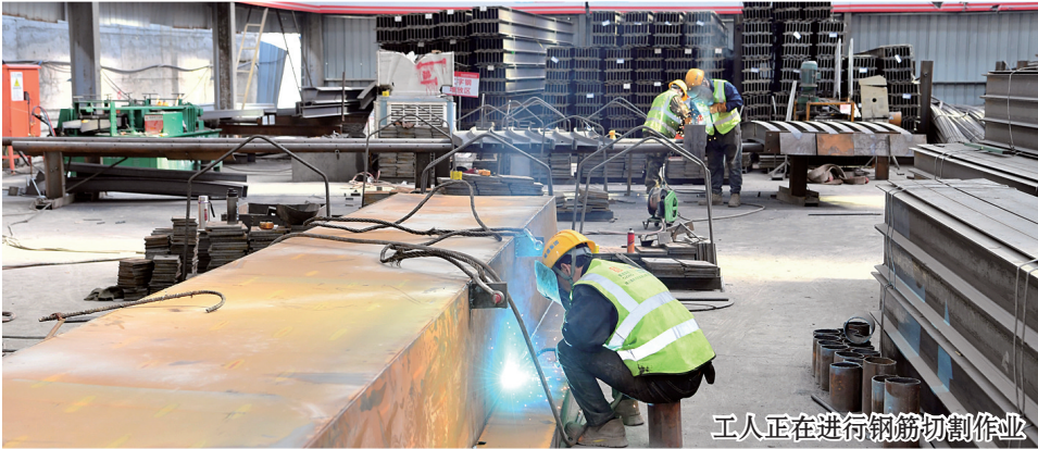
工人正在进行钢筋初割作业
